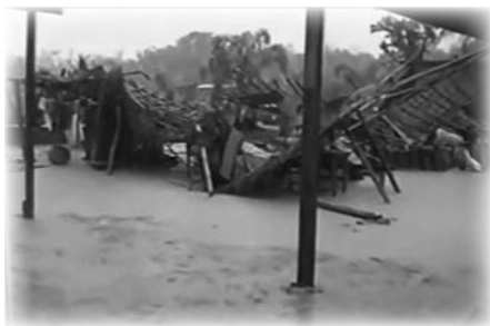
Вторая Церковь Разрушенная Грозой
